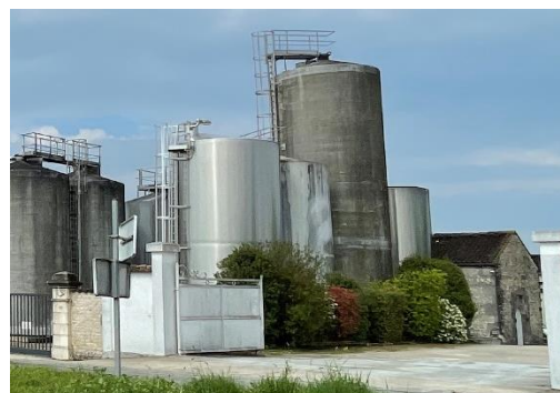
Photo 2 : Accès n° 2 — vue de l'extérieur du site
