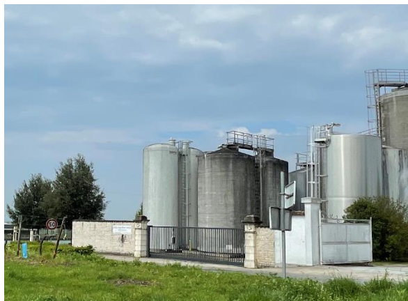
Photo 1 : Accès n° 1 — vue de l'extérieur du site
