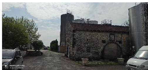
Photo 3 : Accès n° 2 — vue de l'intérieur du site
